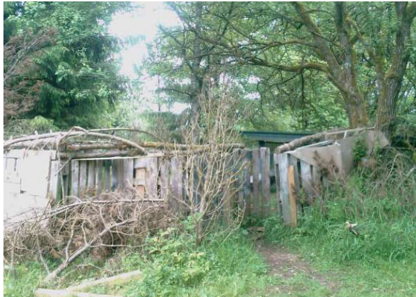
Deckung auf der Geländemarkierung 3
